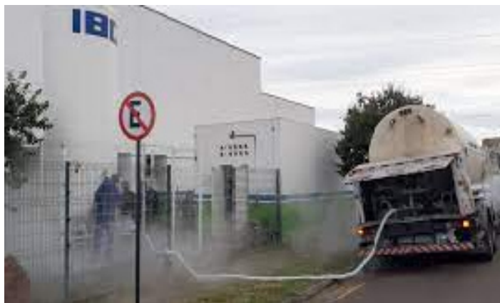
FIGURA 7 – INSTALAÇÃO DE TANQUE DE GÁS MEDICINAL NA UPA AFONSO PENA
