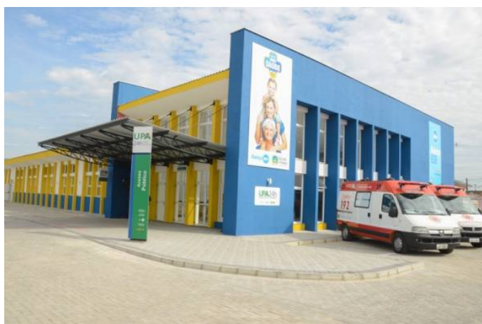
FIGURA 5 – UNIDADE DE PRONTO ATENDIMENTO AFONSO PENA
