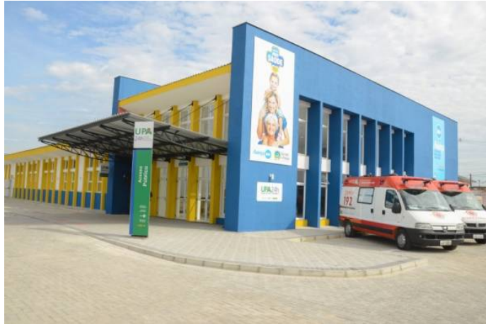
FIGURA 5 – UNIDADE DE PRONTO ATENDIMENTO AFONSO PENA
