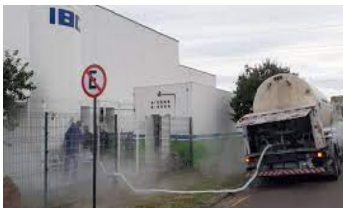
FIGURA 7 - INSTALAÇÃO DE TANQUE DE GÁS MEDICINAL NA UPA AP
