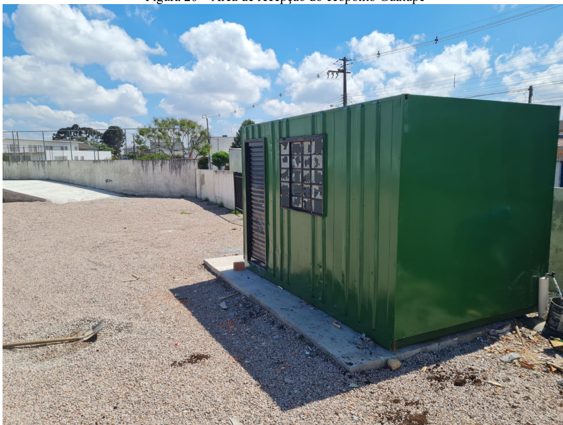
Figura 20 – Área de recepção do ecoponto Guatupê
