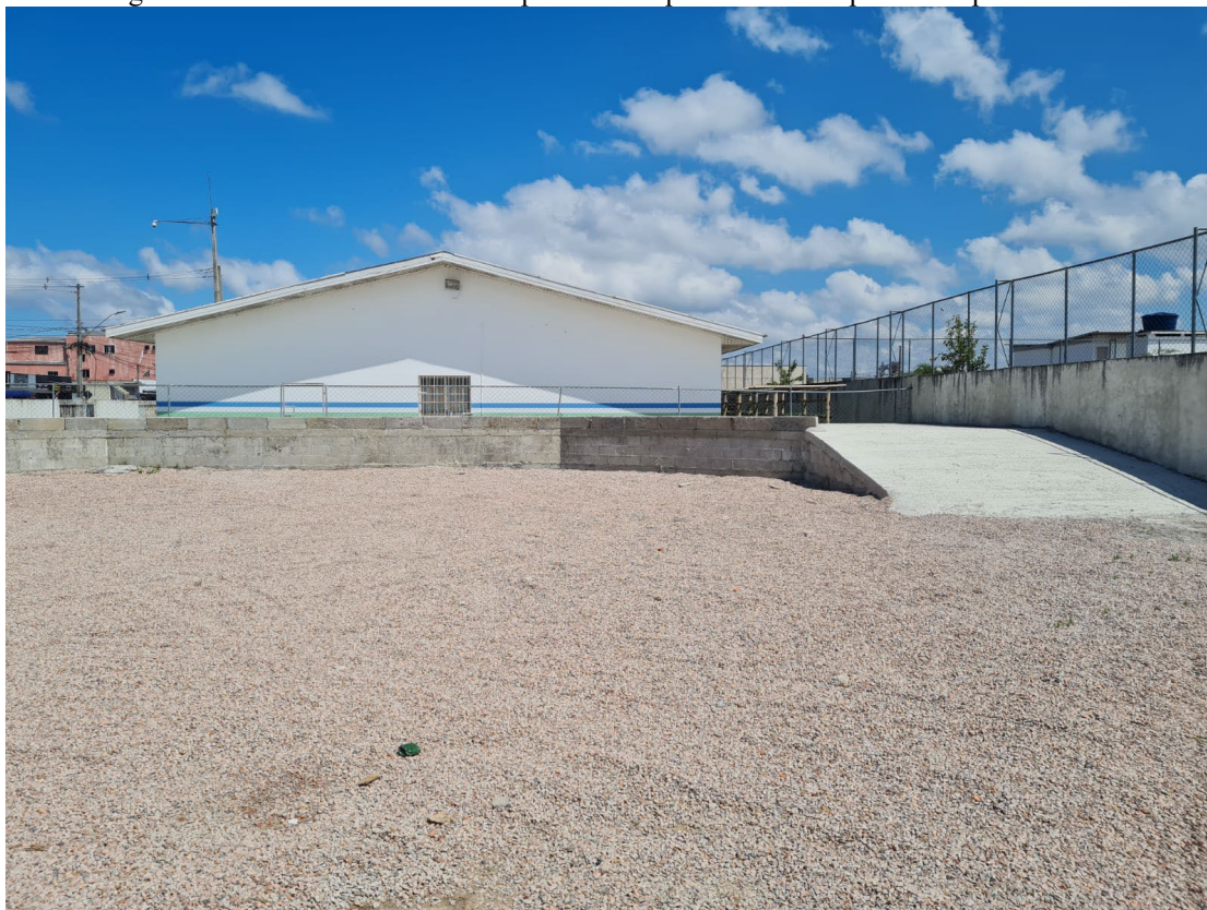
Figura 21 – Vista do interior do ecoponto Guatupê com detalhe para a rampa de acesso
