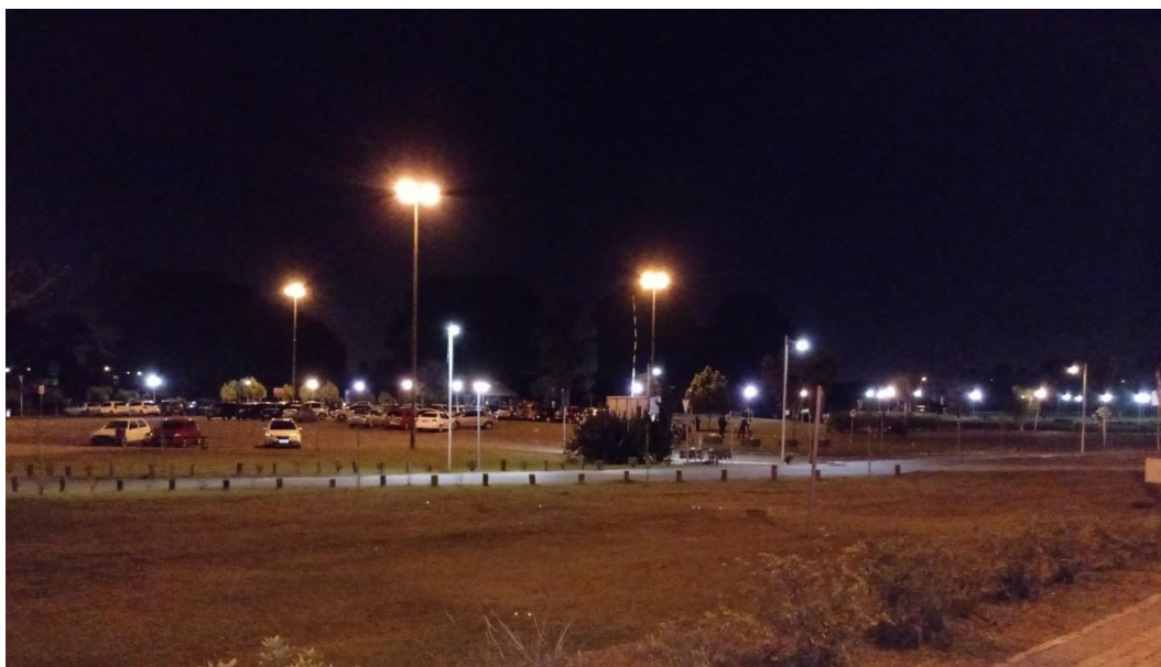
Figura 34: Instalações Luminotécnicas do Parque de Iluminação Pública Municipal – Parque São José
