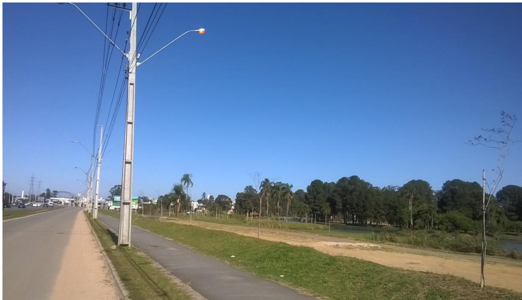
Figura 45: Problemas Encontrados – Avenida das Torres – Parque São José
