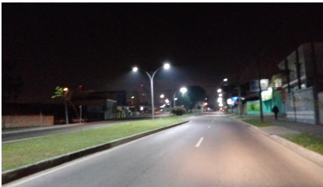
Figura 31: Instalações Luminotécnicas do Parque de Iluminação Pública Municipal – Rua João da Costa Viana
