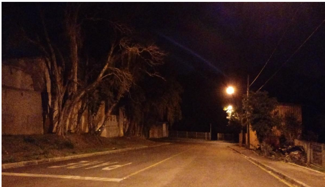
Figura 26: Instalações Luminotécnicas do Parque de Iluminação Pública Municipal – Rua Aristide França
