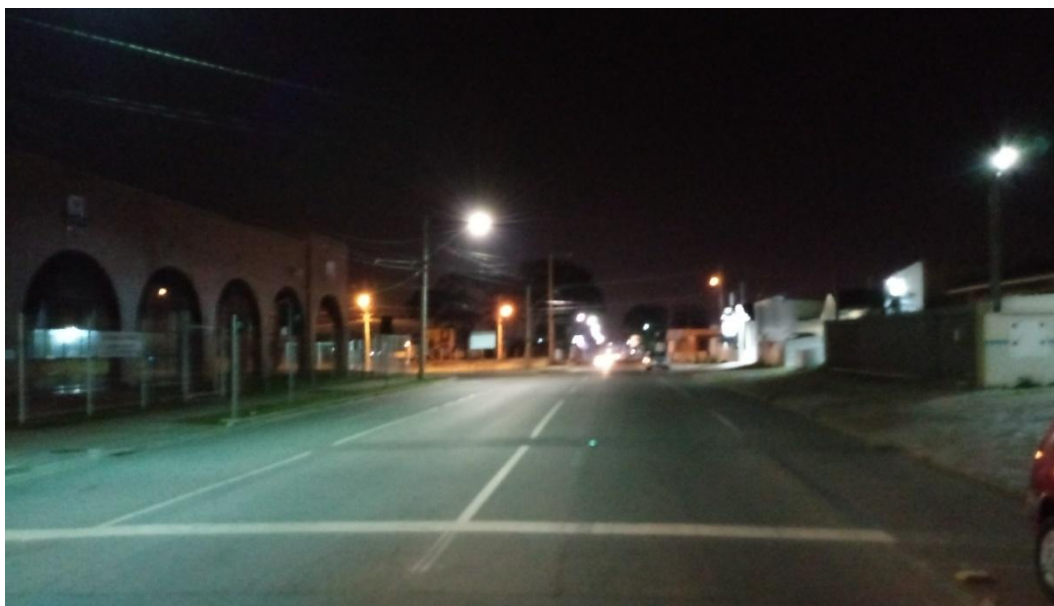
Figura 27: Instalações Luminotécnicas do Parque de Iluminação Pública Municipal – Rua Norberto de Brito
