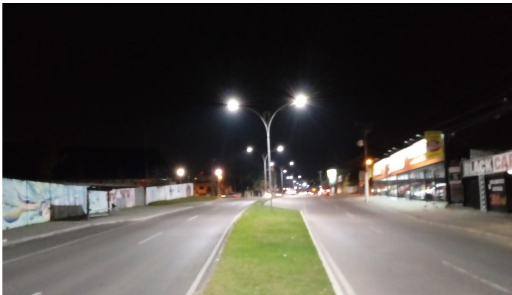
Figura 30: Instalações Luminotécnicas do Parque de Iluminação Pública Municipal – Rua Joaquim Nabuco
