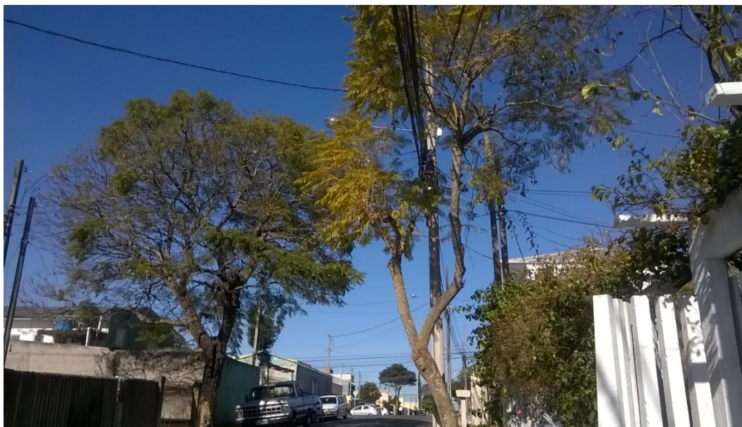
Figura 36: Problemas Encontrados – Rua Ernestina de Macedo de Souza Cortes
